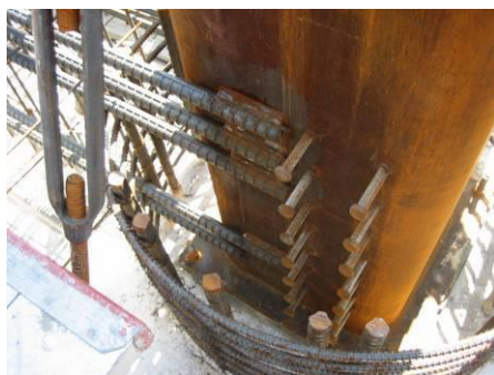
写真 4.1-1 NewJ-BAR を柱脚補強筋として角形鋼管側面に溶接した適用例
